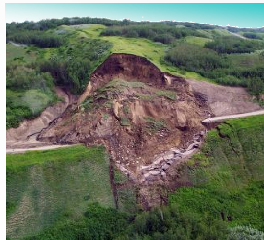
Fig 1 - Glissement de terrain
